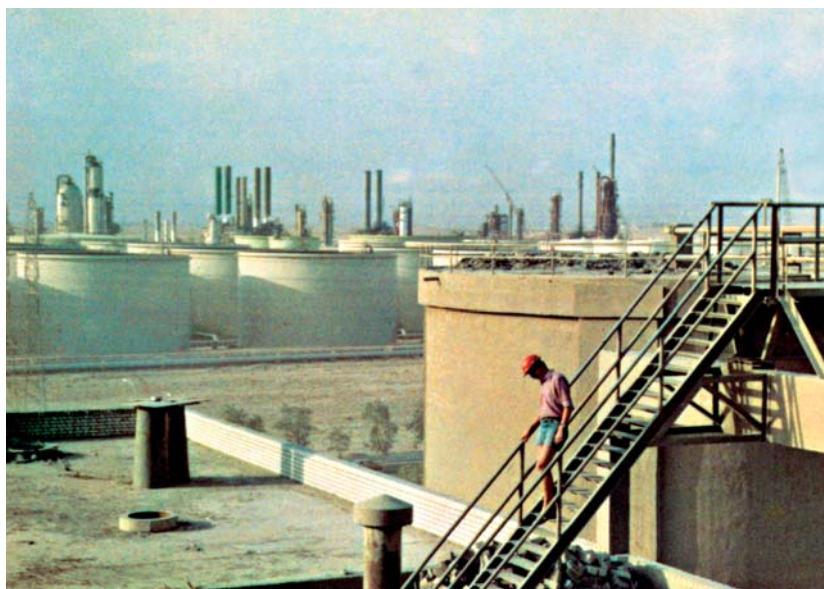
Kuwejt, przemysłownia cementu
