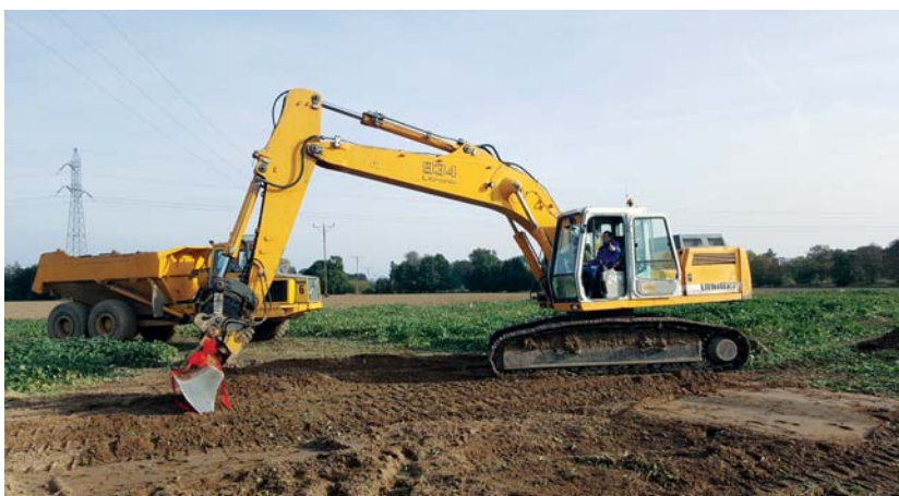
Rozpoczęcie budowy, październik 2016
