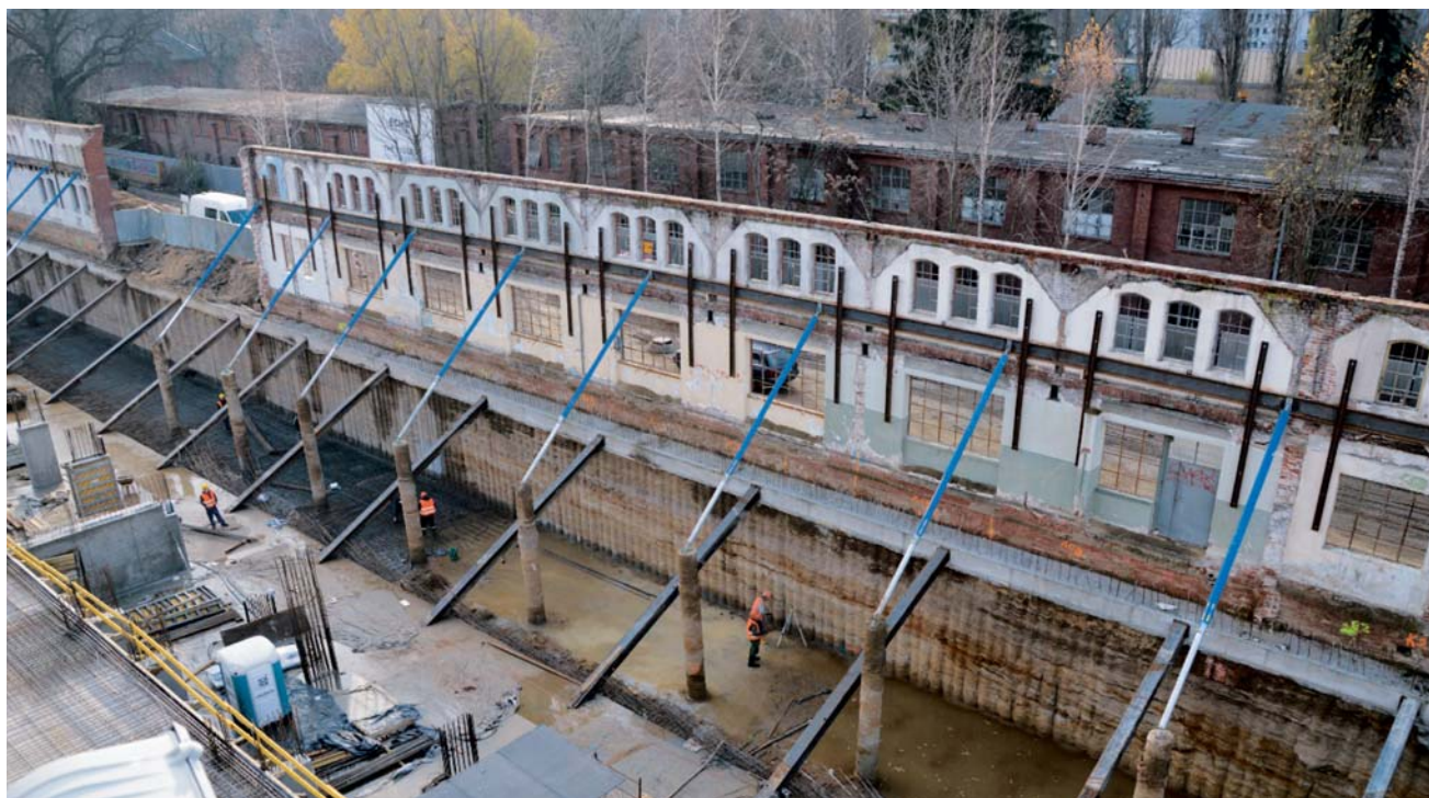
Fot. 3 Zabezpieczenie zabytkowej ściany przy wykopie o docelowej głębokości
