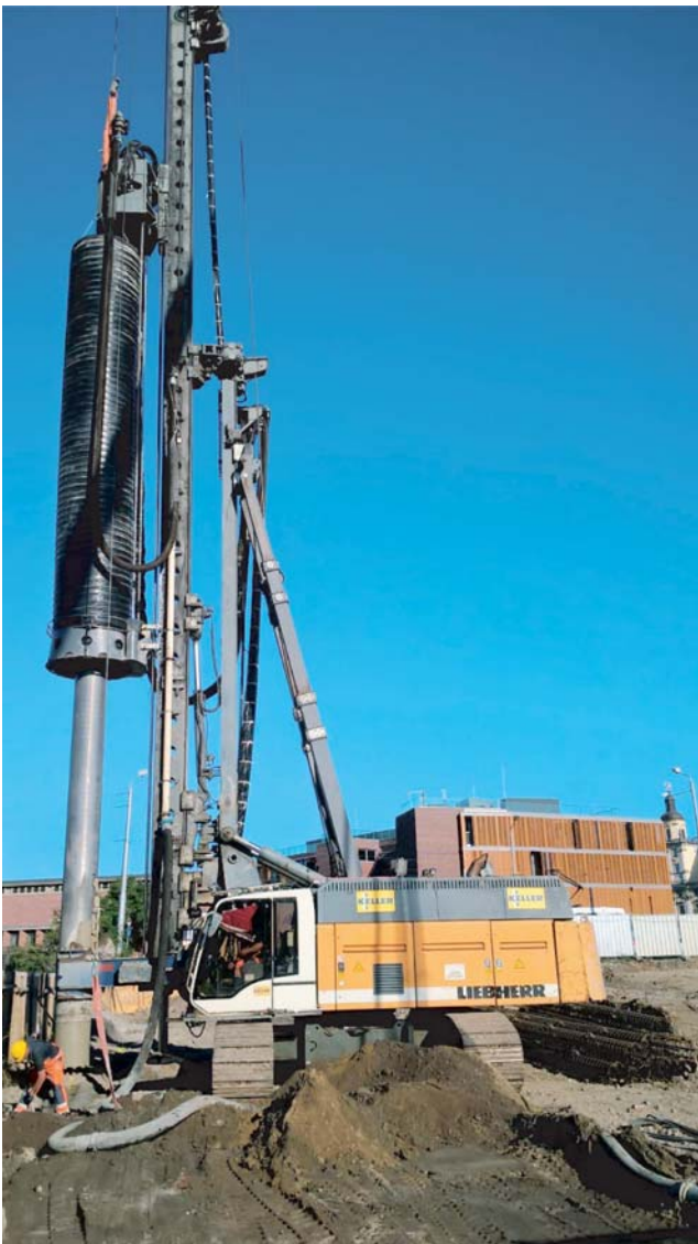
Fot. 5 Wykonywanie pali VDW Ø610 mm
