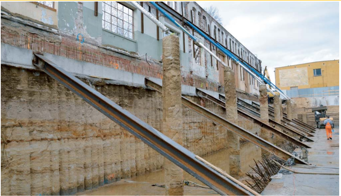
Fot. 4 Palisada zabezpieczająca wykop przy hali nr 19
