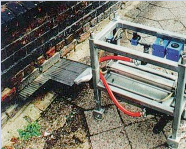
Rys. 6. Widok urządzenia pneumatycznego do wciskania blach w mur.
