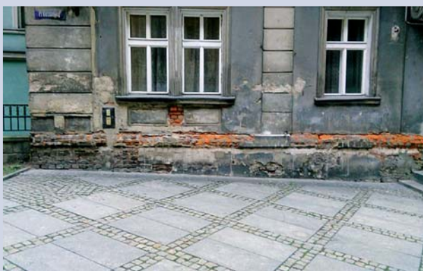
Rys. 2. Przykładowy widok uszkodzeń tynku i muru w wyniku nadmiernego zawilgocenia i mrozu.
