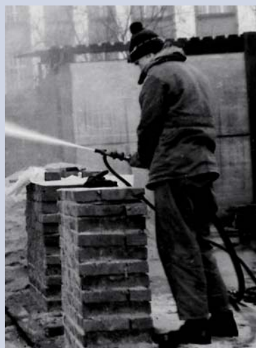
Rys. 5. Widok tryskacza wody (ciśnienie 700 atm).
