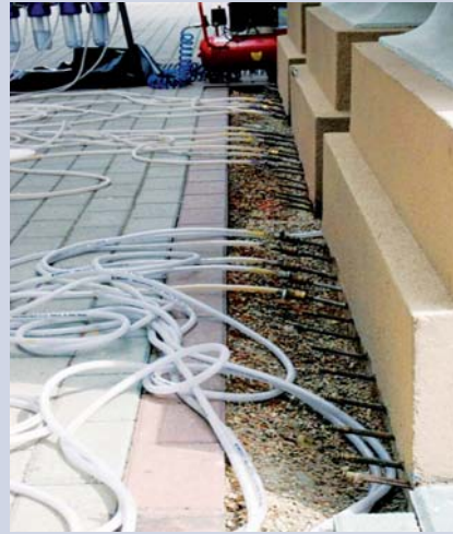
Rys. 8. Widok przewodów i lancy iniekcyjnych do wprowadzania środka w metodzie wysokociśnieniowej.
