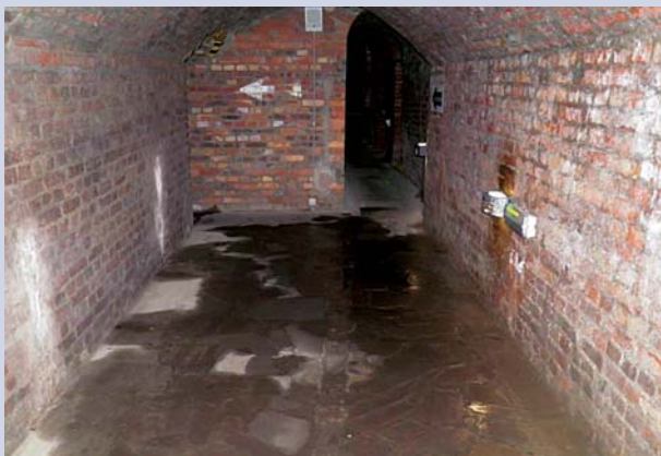
Rys. 1. Przykładowy widok lica muru ceglanego z wykwitami solnymi.
