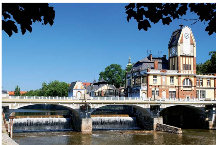
Elektrownia na Łabie
