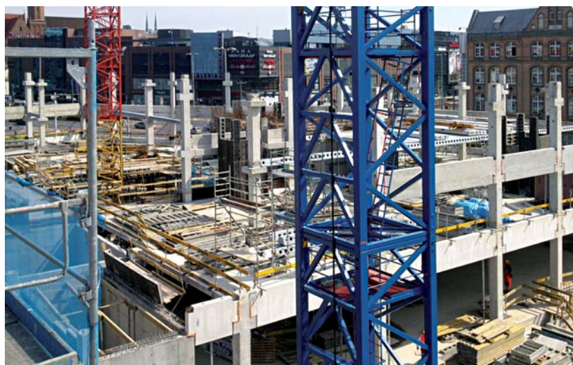
Budowa Biurowca Dominikańskiego
