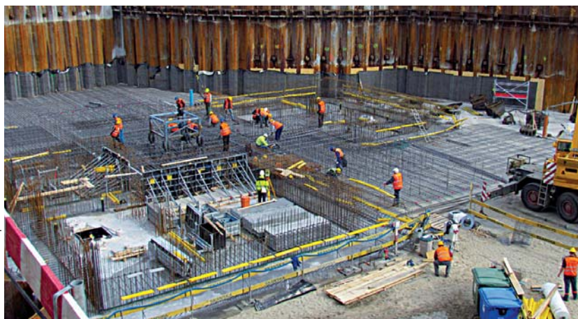
Budowa Biurowca Dominikańskiego
