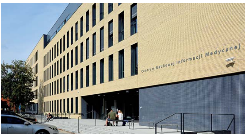
Wyróżnienie w kategorii INSPEKTOR NADZORU INWESTORSKIEGO, inż. Andrzej Sadowski, Centrum Naukowej Informacji Medycznej Uniwersytetu Medycznego
