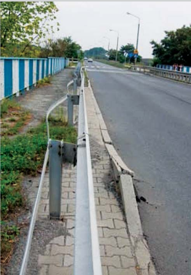
Przykłady powstania deformacje powierzchni w strefach ujawniania się silnych spęzań gruntu. (fot. I. Bryt-Nitarska)
