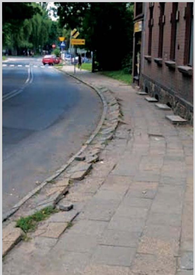
Przykłady powstania deformacje powierzchni w strefach ujawniania się silnych spęzań gruntu. (fot. I. Bryt-Nitarska)
