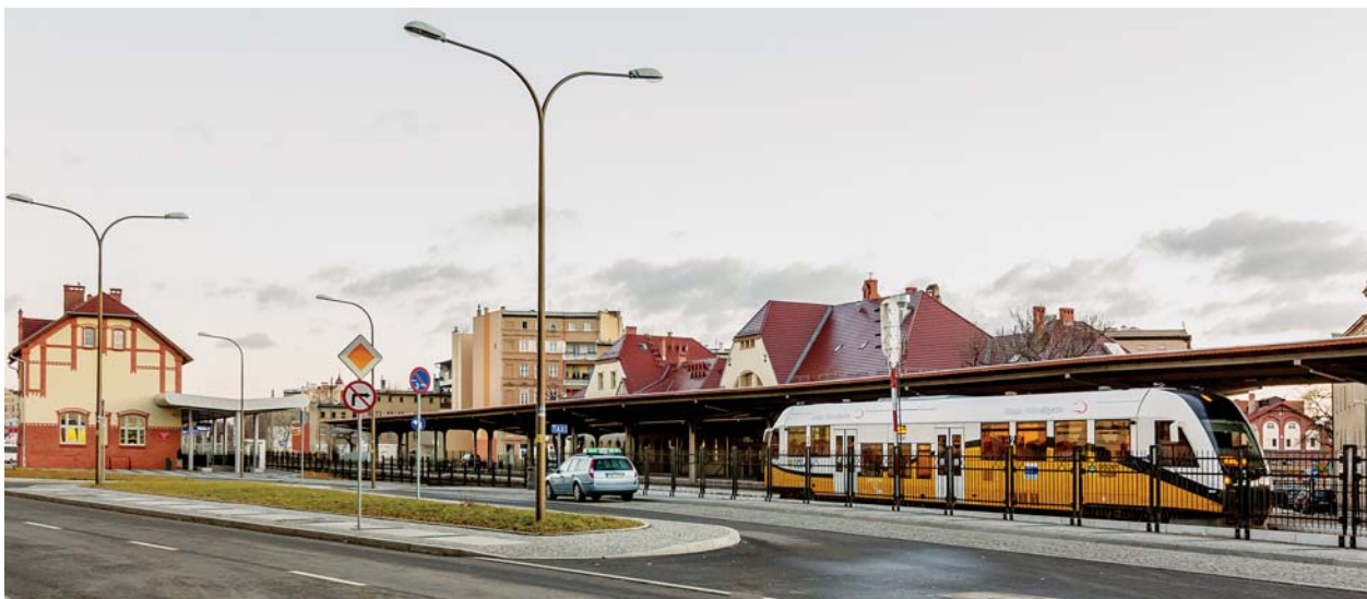
Centrum przesiadkowe w Świdnicy, widok na perony
