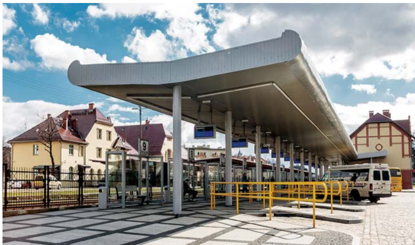
Centrum przesiadkowe w Świdnicy, dworzec autobusowy
