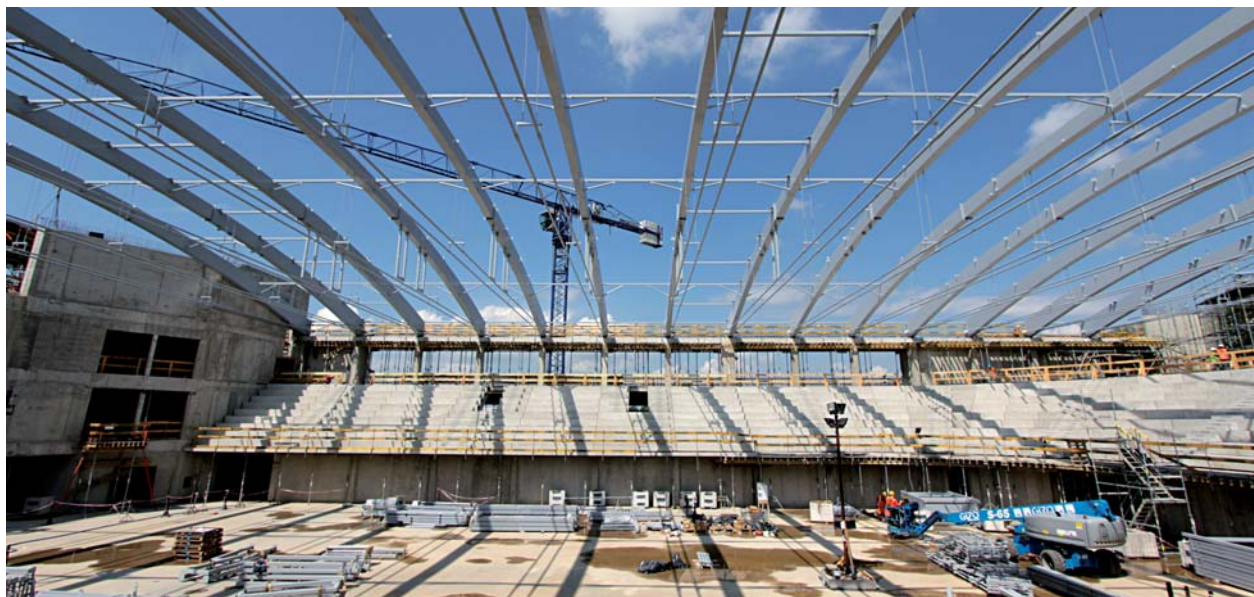
Hala widowiskowo-sportowa, montaż wiązarów
