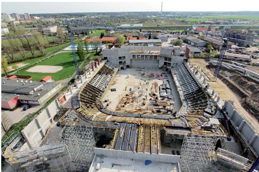
Hala widowiskowo-sportowa w trakcie budowy
