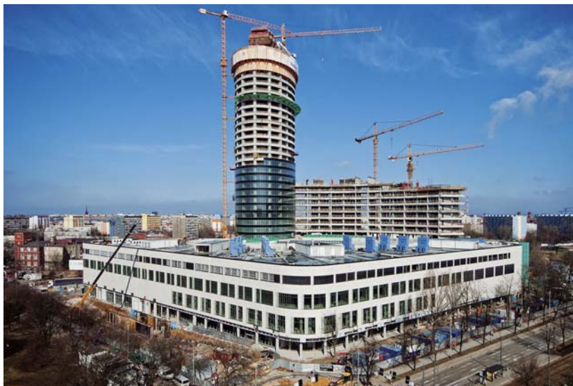
Sky Tower w trakcie budowy, marzec 2011
