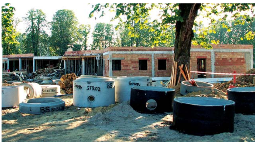
Budynek klubowy w budowie, lipiec 2010
