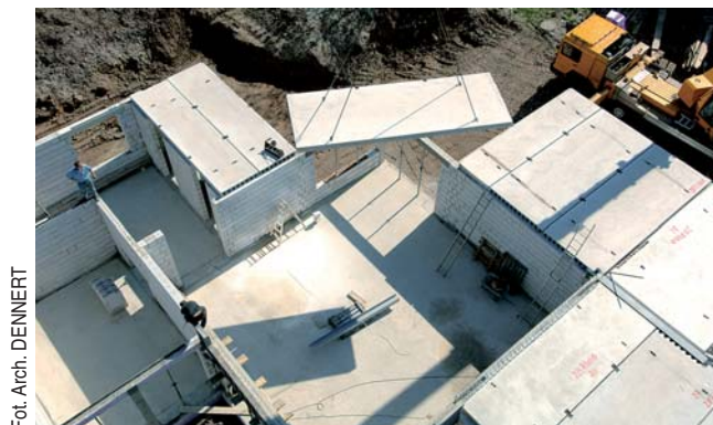
Montaż płyt DENNERT
