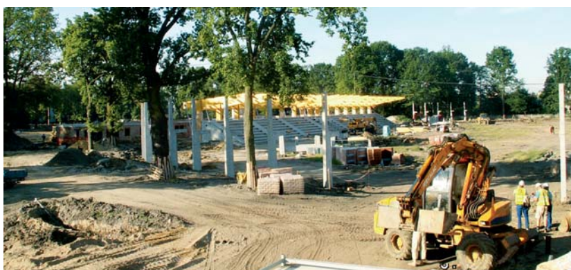
Budowa arkad otaczających główny stadion, lipiec 2010
