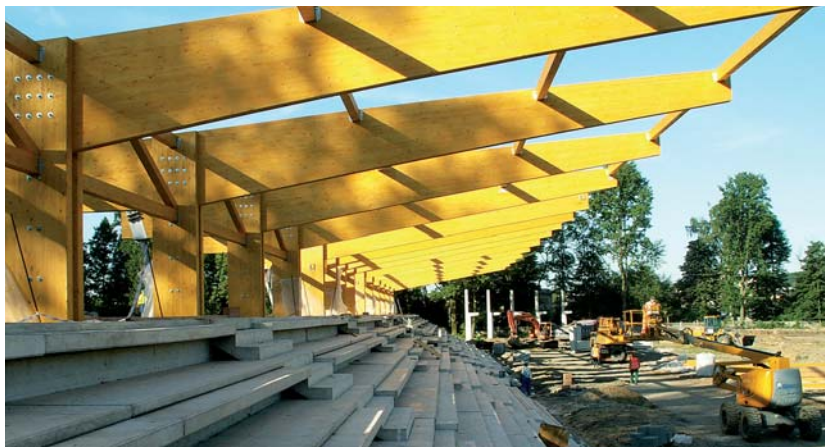
Montaż dźwigarów nad trybuną, lipiec 2010
