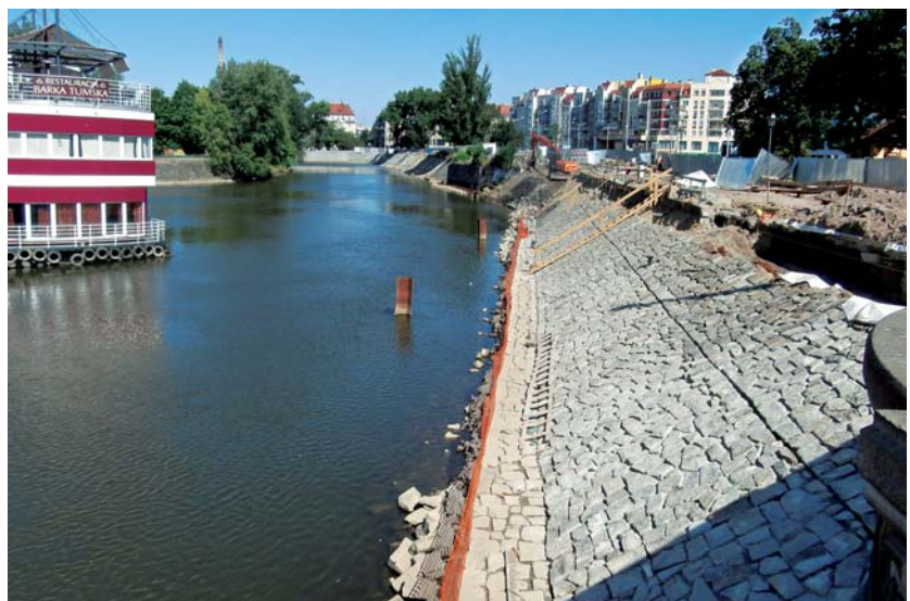
Remont bulwarów Odry Śródmiejskiej
